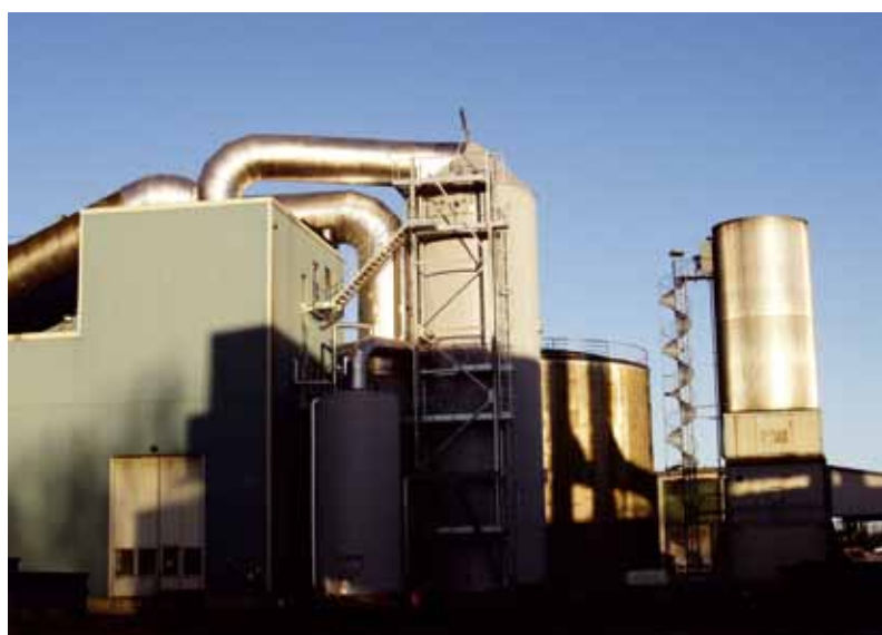
Pilums åtagande innebär ibland ombyggnad av existerande anläggningar med krav på noggrann planering och genomförande under svåra förhållanden.
